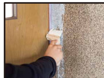
④2時間程度でシーラーが乾いたら、2回目、3回目と厚塗りになるように塗り重ねる。
