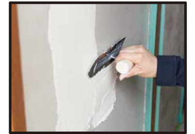
③2で塗り付けた材料の隣(利き手側)に同じように数列塗り付けていく。
