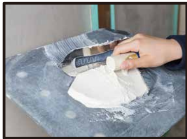
①コテ板の遠い部分にある材料をコテで切る。
