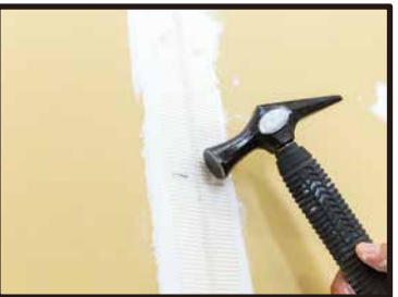
⑧タッカーの針が浮いている場合は、ハンマーなどでたたき込んでしっかり固定。
