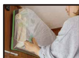
コロナマスカーのビニール を内側にまとめて養生テー プで固定する。
