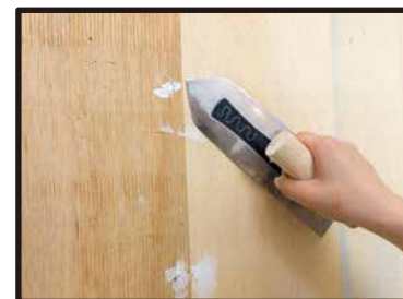
⑤シーラーが乾いたら、パテ材でビス頭を埋めて平らにする。
