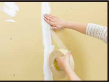
⑥継ぎ目にジョイントテープを貼る。
