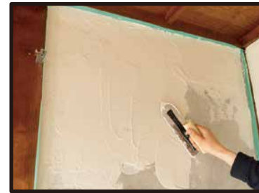
③隙を塗り終えたら、広く残っている部分を塗り進める。
