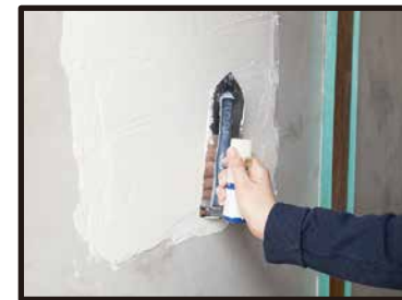
⑤進行方向側のコテの刃を1cmくらい浮かせて、スライドさせながら平らにする。
