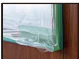
巾木と同様に壁から1～ 2mm隙間をあけてマスキン グテープ、コロナマスカーの 順で貼る。
