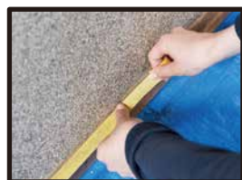
壁から1～2mm(しっくい 塗り厚の分)隙間をあけて、 マスキングテープを貼る。
