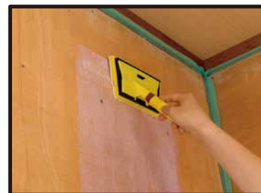
④一度目のシーラーが乾いたら再度重ねて塗る。シーラーを塗る回数は最低2回、推奨3回。
