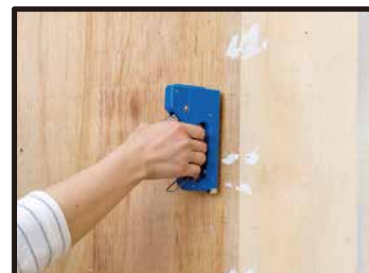
⑦しっくいを塗っている最中にジョイントテープが剥がれてくるのを防ぐため、ジョイントテープをタッカーで固定する。タッカーを打つ間隔は15～20cm程度。
