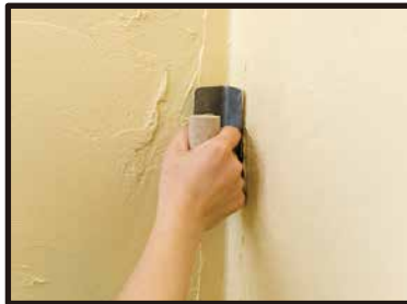
②進行方向の刃を浮かせながら下へスライドさせる。
