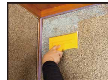
③広い部分を塗り残しがないように大きめの刷毛かコテバケ、スポンジローラーで一気に塗る。
