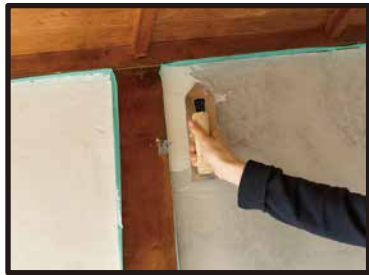
①利き手と反対側の隅、上の方から塗り始めて、天井との際を埋める。
