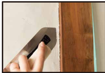
②養生を剥がした際にけげばけがしている場合は、金属ヘラで際を押さえて整える。
