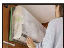
コロナマスカーをエアコン 本体に直貼りする。
