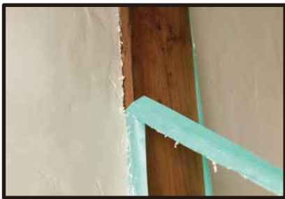
①養生を引っ張りながら、ゆっくり剥がしていく。
