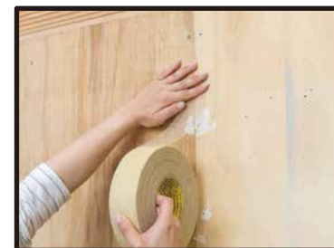
⑥ベニヤの全ての継ぎ目にジョイントテープを貼る。
