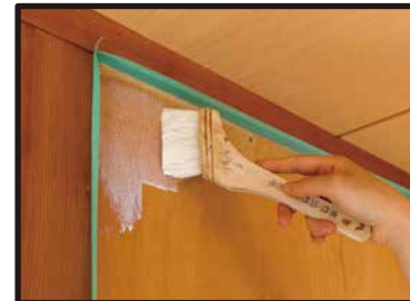
③他の下地とは異なり、継ぎ目を固定する前にシーラーを塗る。
