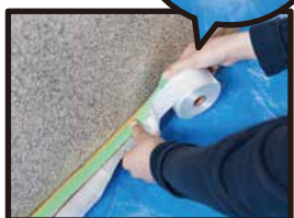
マスキングテープの上から コロナマスカーを壁側へは み出さないように貼る。
