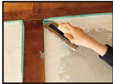
②下へ塗り進めて、ムラができないように気をつけながら壁の隙を塗る。
