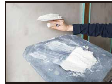
④コテ板から離れたら、そのまま壁に付ける。
