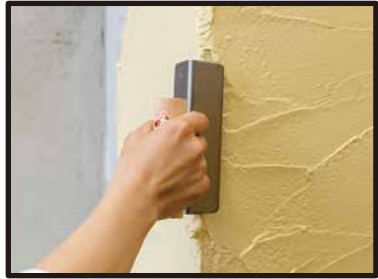
①出隅コテの先の部分を壁に当てる。
