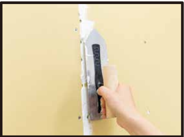
③パテ材でボードの継ぎ目を埋める。
