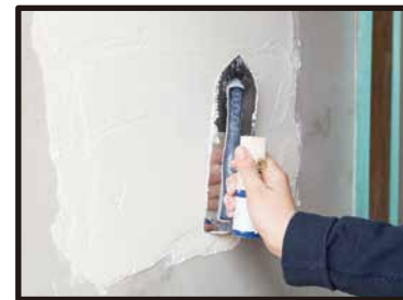
④コテ板に載っている材料を全て壁に塗り付けたら、材料を横へ伸ばす。
