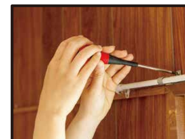
ドライバーで金具を外す。 (金具・部品類は保管)
