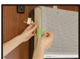
コードを養生テープでエア コン本体に貼り付ける。
