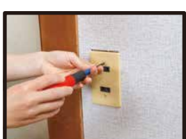
ドライバーでカバーのビスを 取り外す。(金具・部品類は保管)
