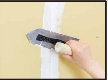
④余分なパテ材を削り取って段差をなくし、平らにする。
