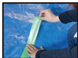
コロナマスカーと床養生を 養生テープで貼り合わせて 固定する。
