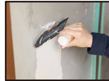
②コテを少しずつ上に向かって寝かせながら材料を壁に付けていく。
