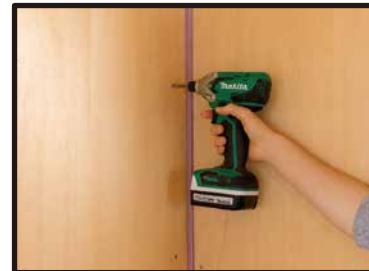
②下地がたわむ場合はしっくいが割れやすいので、ビス打ちをして補強する。
