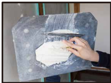
③コテ板から材料をコテに載せるようにして、上に押し上げてコテ板から離す。
