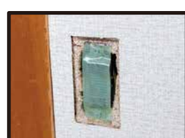
コンセント部分を養生テープを直貼りして養生。
