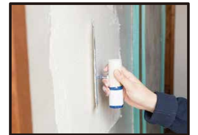
⑥壁にしっかり圧力をかけながら、平らに塗っていく。
