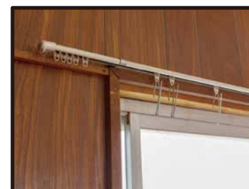
カーテンレールは外して養生。
