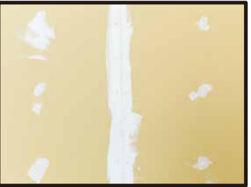
⑤パテ材を埋めて、すべての段差をなくす。
