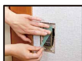
コンセント部分を養生テープを直貼りして養生。
