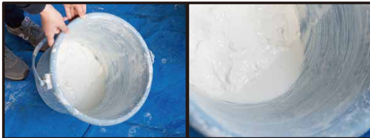
①バケツのうわ水のみを排水溝に捨てる。
