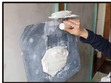
③コテ板から材料をコテに載せるようにして、上に押し上げてコテ板から離す。
